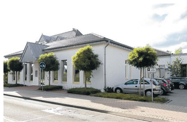
Die zahnärztliche Gemeinschaftspraxis Kohl-Heers an der Dülmener Straße, so wie man sie schon lange kennt. Die Erweiterungsfläche befindet sich hinter dem Gebäude.
